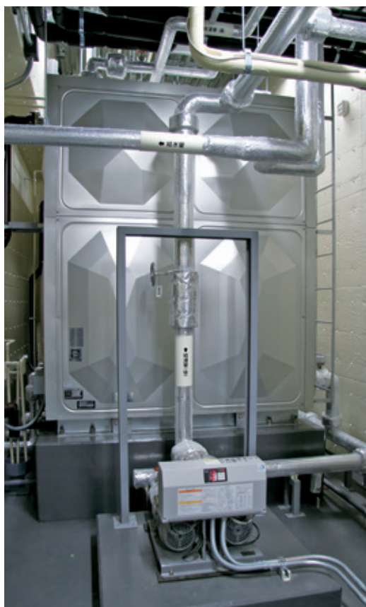
▲貯湯タンクは放熱と防虫対策のため機械室内に設置。タンク内は中仕切によって2槽化しているが、連通管で接続
