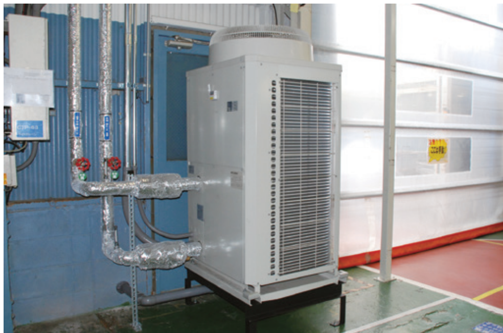
▲洗浄設備と同じ施設内に設置された ホットウォーターヒートポンプ CAHV-P250AK-H
