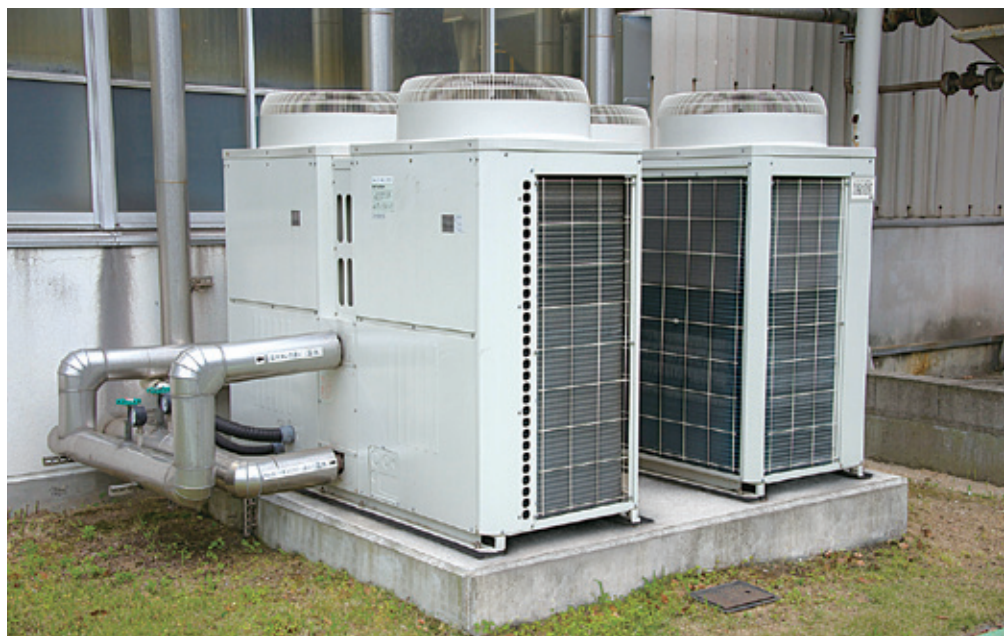
◀工場横に連続設置された ホットウォーターヒートポンプ CAHV-P500AK-H-BS × 2台
