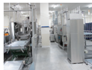
▲洗浄脱水ラインはフルオートで毎時2,000枚の洗浄が可能
