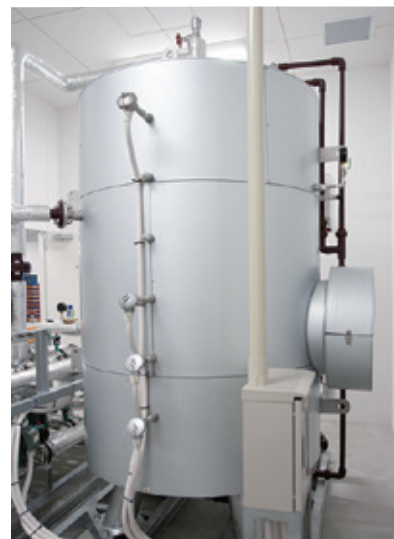
▲貯湯槽は密閉型で呼称容量2トン(有効貯湯量1.78m 3 )。別室にあり、温水配管は天井を通している。
