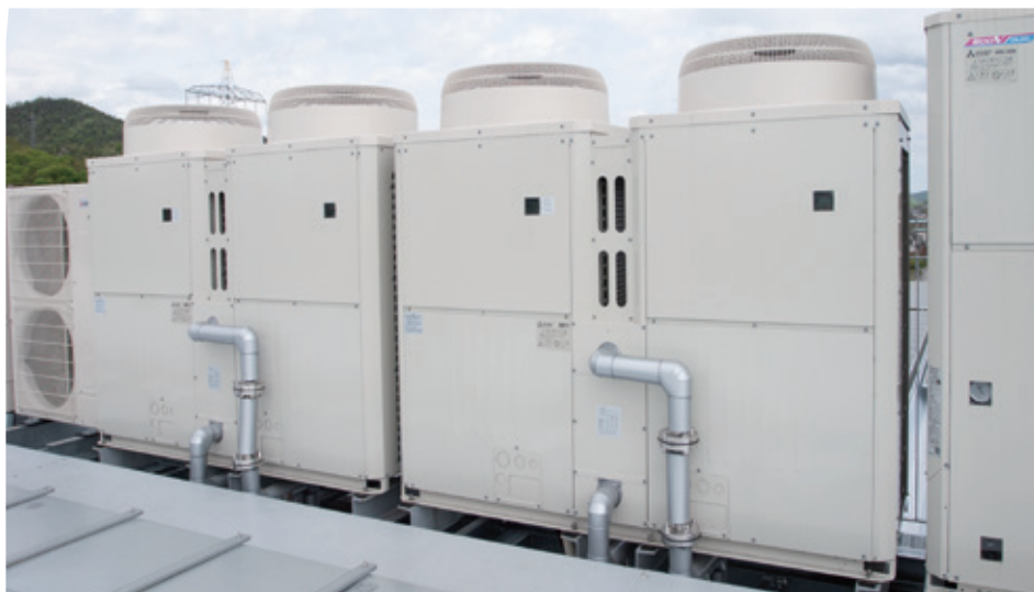
▲洗浄用温水の熱源機は三菱電機のホットウォーターヒートポンプ。センターの屋根上に設置
