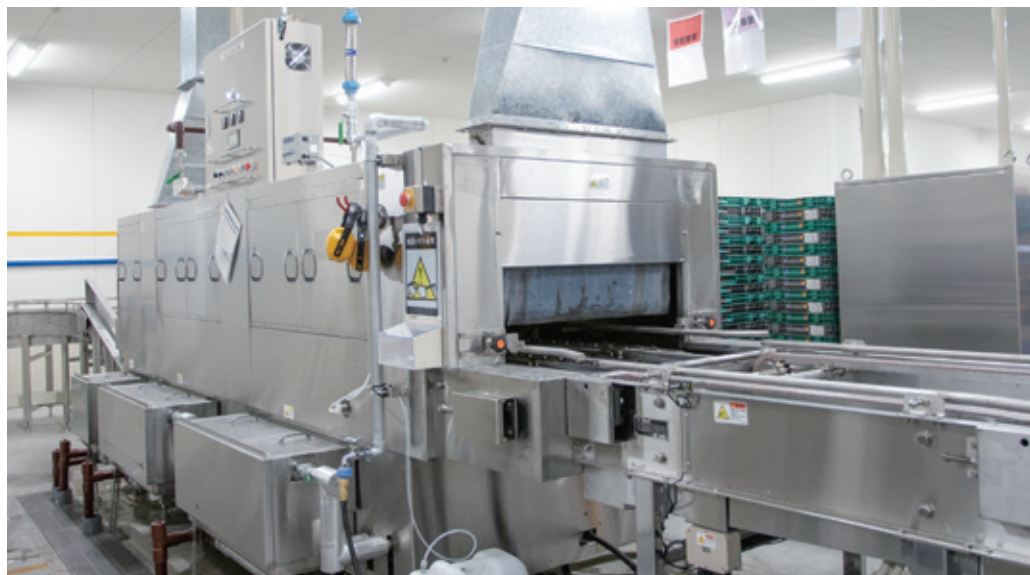
▲番重洗浄には温水が不可欠。これは洗浄機の本体
