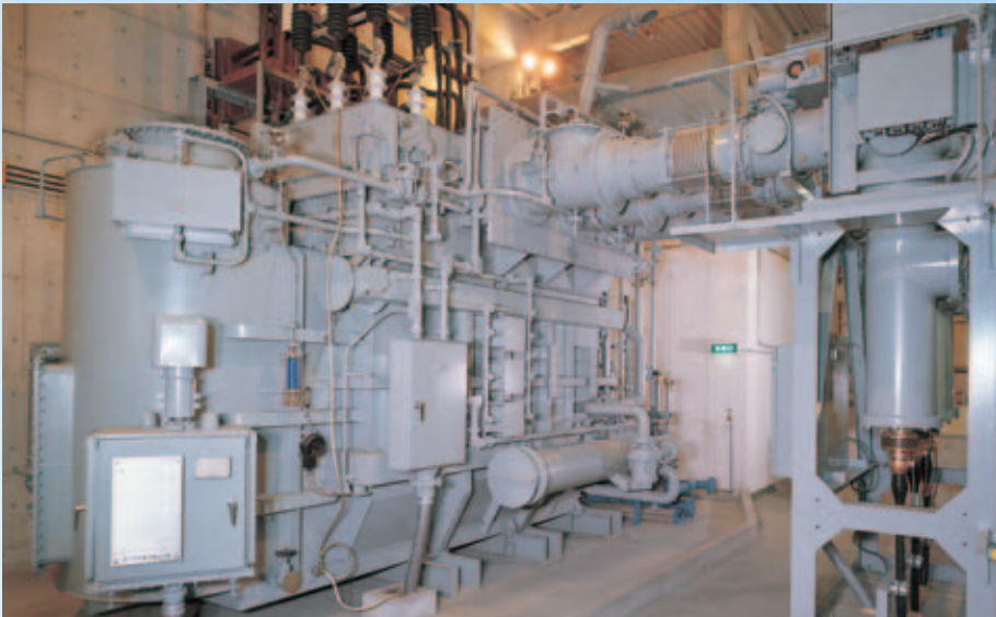
写真 9 合金鉄炉普通形ブッシング
