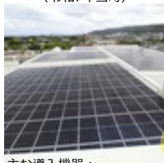
主な導入機器： パネル 185kW 蓄電池 13.5kW CO2削減量 254t
