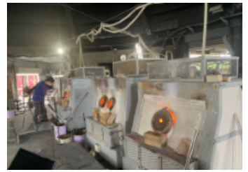
琉球ガラス村では溶融炉、徐冷炉として電気炉を使用しています
