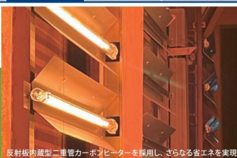
反射板内蔵型二重管カーボンヒーターを採用し、さらなる省エネを実現
