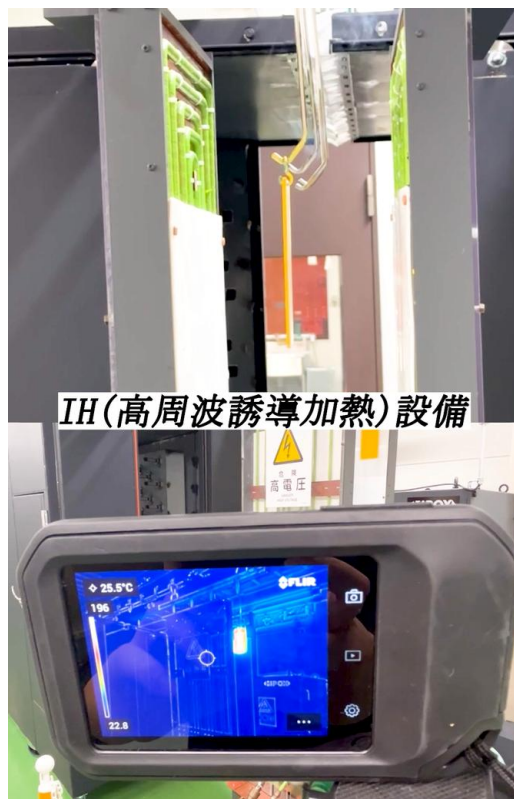
Step1(IH)：粉体塗料の仮止め溶着
